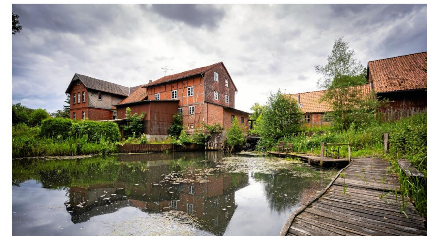
Bereits im Frühjahr wurde der Mühlenteich entschlammt, jetzt das alte Wehr saniert. Finanziert wurde das Projekt durch öffentliche Fördermittel und auch durch private Initiativen.
